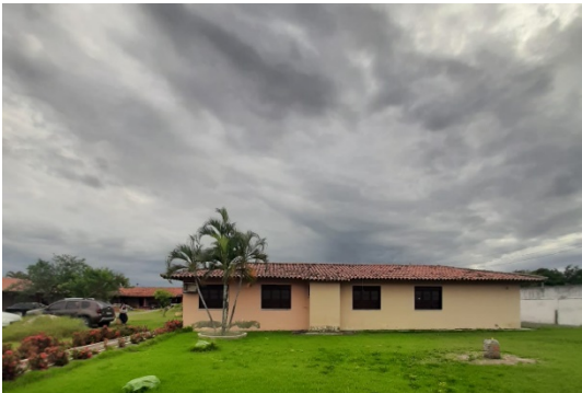
Figura 13 - Local onde foram realizados os ensaios. Fonte: Autores.
