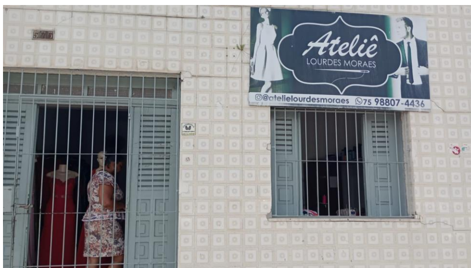
Figura 2 - Fachada do Ateliê.
