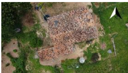
Figura 10. Telhado da cede da propriedade. Fonte: Próprio Autor.
