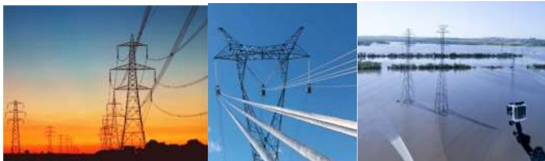
Figura 1 - Exemplos de linhas aéreas de transmissão de energia elétrica
