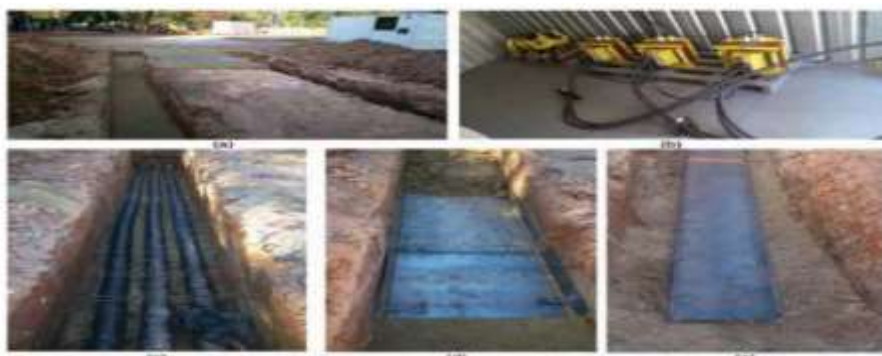
Figura 5 - Exemplo de LTS com o cabo condutor.
